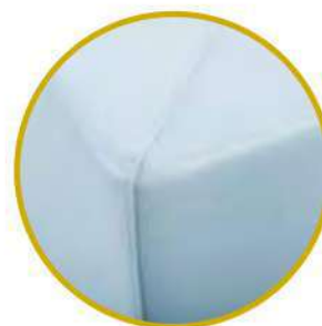
Particolare della cucitura sulla struttura della piscina
